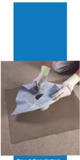
Posa di Drain Vertical plastico di riserva, su Mapelastix
