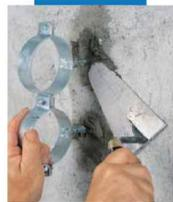
Fissaggio di collari per tubazioni con Lampocem
