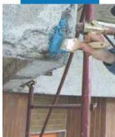
Applicazione a pennello di Mapefer 1K sui ferri di armatura di un balcone in calcestruzzo armato
