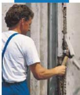
Demolizione del calcestruzzo degradato
