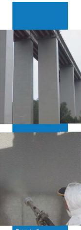
Esempio di applicazione a spruzzo di Mapelastix in un vuoto
