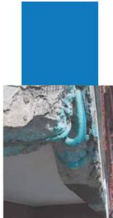
Ferri di armatura del frontone di un balcone rivestiti con Mapefer 1K
