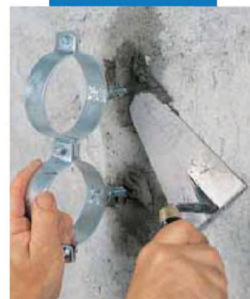
Fissaggio di collari per tubazioni con Lampocem
