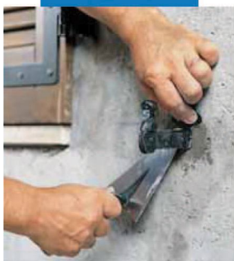
Posa di zanche per finestre con Lampocem
