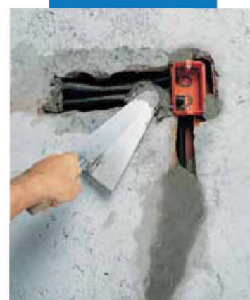
Fissaggio di scatole e tubazioni elettriche con Lampocem
