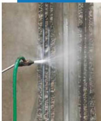
Pulizia dei ferri con idrosabbatura
