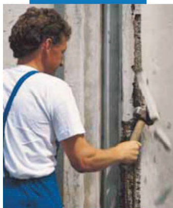
Demolizione del calcestruzzo degradato
