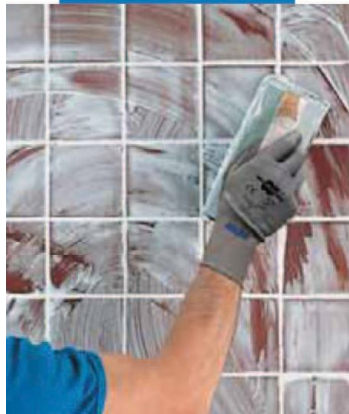
Stesura con spatola gommata
