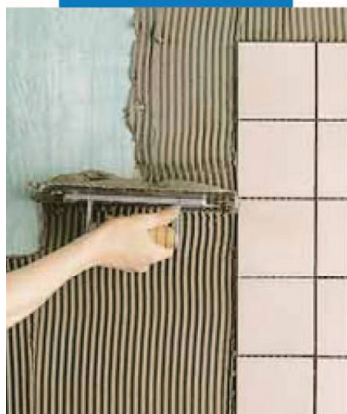
Posa su gesso trattato con Primer G
