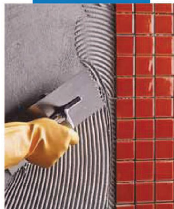
Posa a rivestimento di mosaico ceramico
