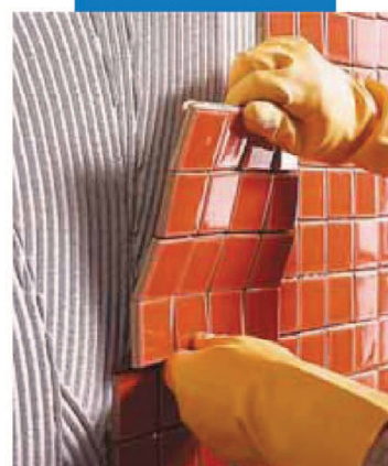
Posa a rivestimento di mosaico ceramico
